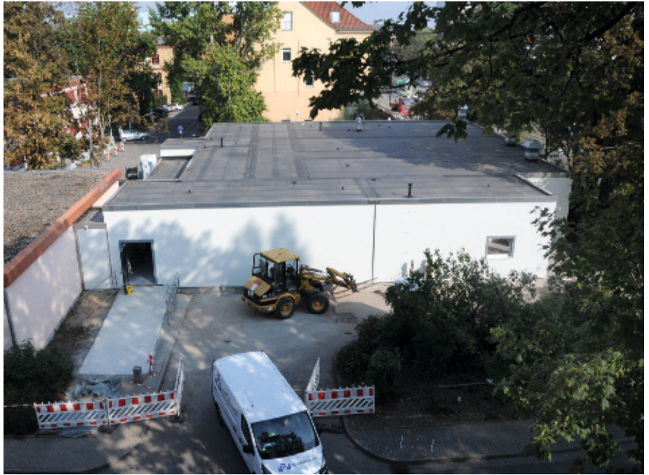
Das Domizil des OP-Bereiches der Herzkl. mit 14 Container-Modulen ist komplett.
