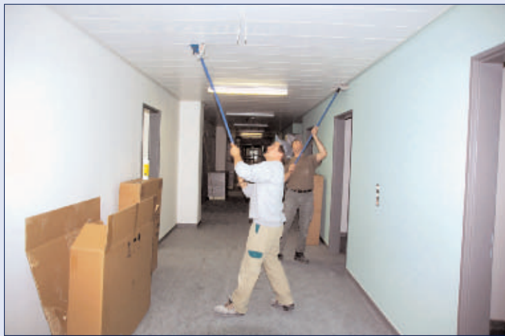
Der Innenausbau im zweiten Bauabschnitt im Haus 60 läuft auf Hochtouren.
