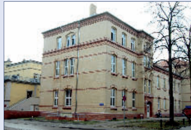
Der Innenausbau im Haus 2 geht zügig voran.
